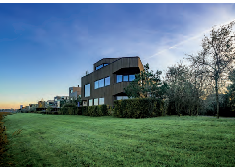
Gevel op het noorden aan de waterkant, de gevels zijn bekleed met Ayous delen.
