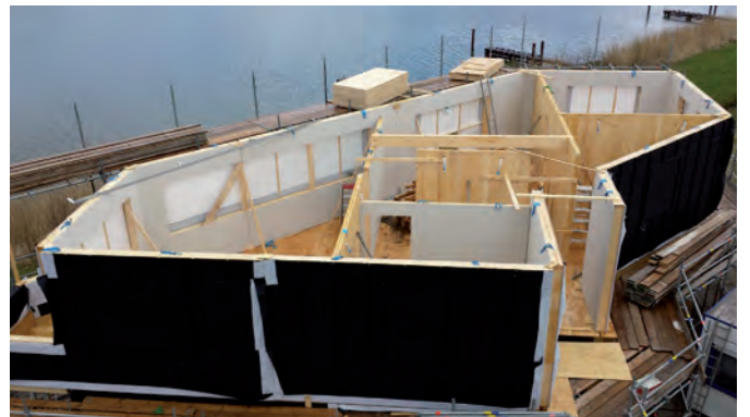
De draagconstructie van de woning – hier de eerste verdieping – bestaat uit kruislaaghout. De constructie is verder ingevuld met houtskeletbouw.
