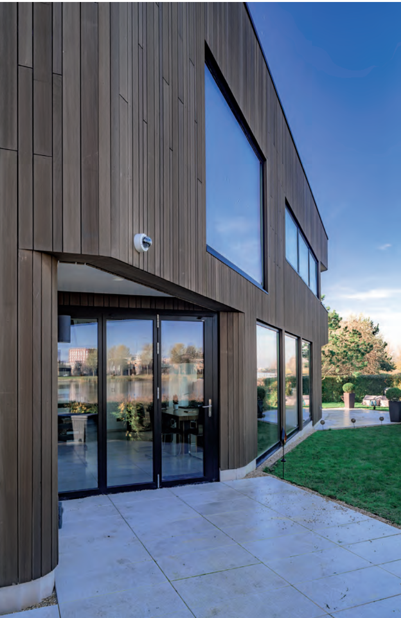
Gevel op het noorden aan de waterkant, de gevels zijn bekleed met Ayous delen.
