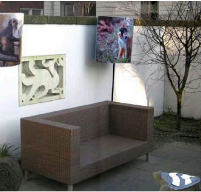
In de tuinmuren heeft Spaans Bouwsystemen sparingen opgenomen voor het later plaatsen van uittbundige reliëfstenen
